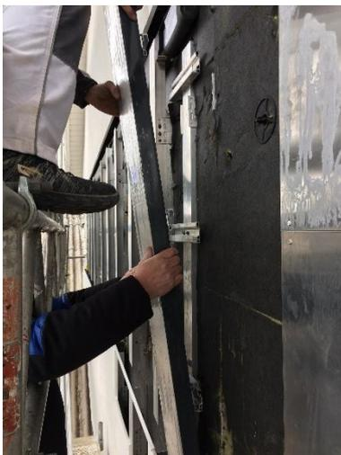
Bauphase: Die Montage der Solarkollektoren gelingt einfach durch Einhängen in die Agraffenprofile.
