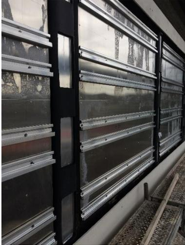
Vorgehängte hinterlüftete Fassade mit Sammelkanal (Mitte) zur Wärmeaufnahme und Agraffenprofilen zur Fixierung der Kollektoren
